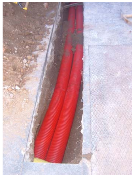
Foto 6. Canalització del nou cablejat elèctric al llarg de la rasa 1.
