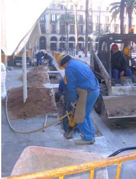
Foto 1. Realització de la rasa 2.
